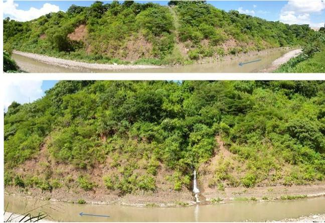
Figura 138. El pendiente inestable del lugar del “A” (lado del Río Choluteca). Una parte del terreno pendiente está inestable (Figura 139). La vereda se derriba parcialmente (de abajo de la Figura 139).
