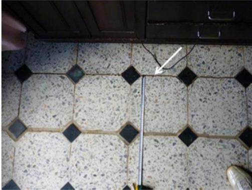
Figura 28. La grieta del piso de la casa (fuera del cuerpo de deslizamiento principal)
