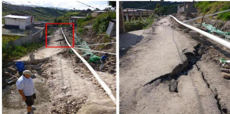
Figura 24. Izquierda: grietas, derecha: agrandamiento de la grieta
