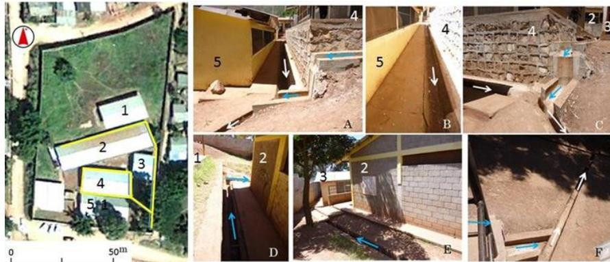
Figura 112. Los canales abiertos alrededor de la escuela (flechas: las direcciones de las corrientes). A causa de las dimensiones pequeñas del canal, las aguas se desbordan y hace que los alumnos se metan en el canal, pudiendo provocar accidentes personales. Se recomienda instalar una rejilla sobre el canal.
