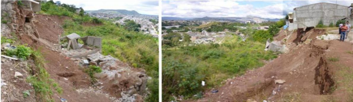
Figura 53. El estado del relleno con las grietas
