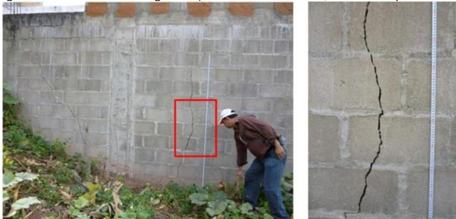
Figura 57. El estado de la grieta en la pared
