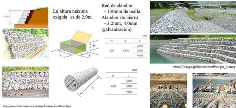
Figura 189. Ejemplos de las obras de los gaviones (cestos de las piedras).
