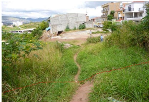
Figura 54. El estado del relleno con la grieta
