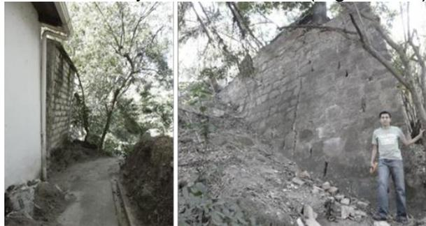
Figura 129. Grietas en el muro.
