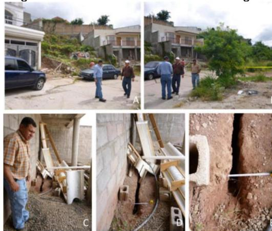
Figura 56. El estado de las grietas (C-E: 10 cm de ancho, 140 cm de profundidad)
