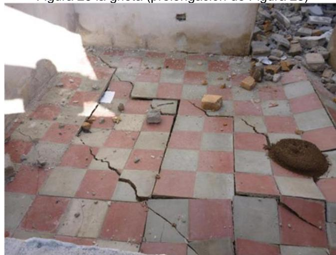
Figura 27. Las grietas sobre el piso en el cuerpo principal
