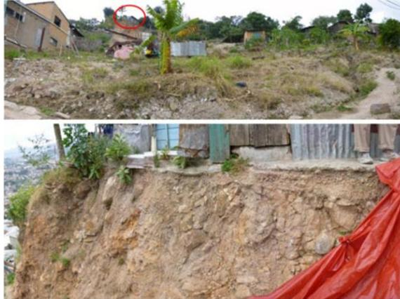
Figura 35. El derrumbamiento de suelo
