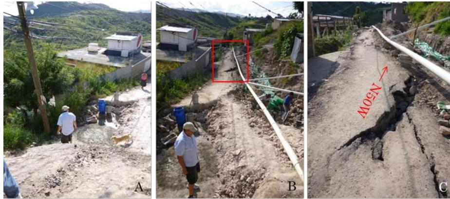
Figura 69. La vista de la destrucción sobre la calle (por la cabeza del deslizamiento). La Figura 70 representa la grieta del lado del deslizamiento de tierra. La grieta continúa por detrás de la casa (Figura 70-A). Hay una falla cerca del lado del deslizamiento (Figura 70-B y 70-C: NS53°W).
