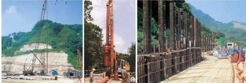
Figura 191. Ejemplo de las obras de los pilotes de tubos.
