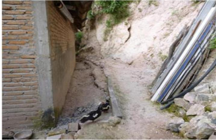
Figura 25. La grieta cerca de la corona del deslizamiento
