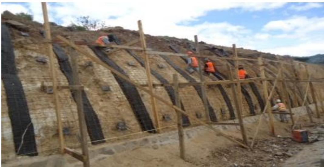
En los últimos años, el suelo clavado ha cobrado un gran auge en Honduras, siendo muy utilizado tanto en proyectos de edificación para la construcción de muros en sótanos, en proyectos viales para construcción de muros en accesos a cajas puente (“túneles”) y en proyectos en carreteras para estabilización de taludes de corte. A continuación se mencionan algunos de estos proyectos.
