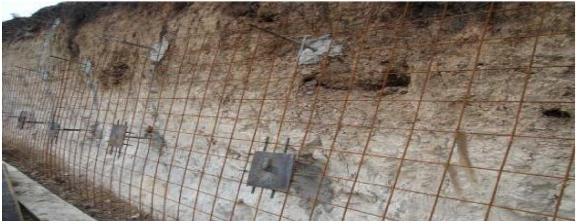
Los diámetros del agujero del anclaje van desde 3” a 6” de diámetro interno y por lo general se utilizan varillas de construcción corrugadas convencionales con diámetros entre 20 y 40 mm (Ortuño L., 2010).
