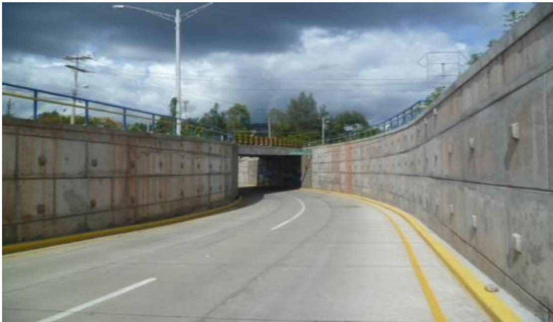
La aplicación mostrada en la figura 10 es un caso típico de aplicación de un muro Soil Nail. Este tipo de muros tiene la ventaja que permite realizar de forma simultánea, la obra de corte y la obra de contención de tierras permitiendo ahorro de tiempo y costos del proyecto.
