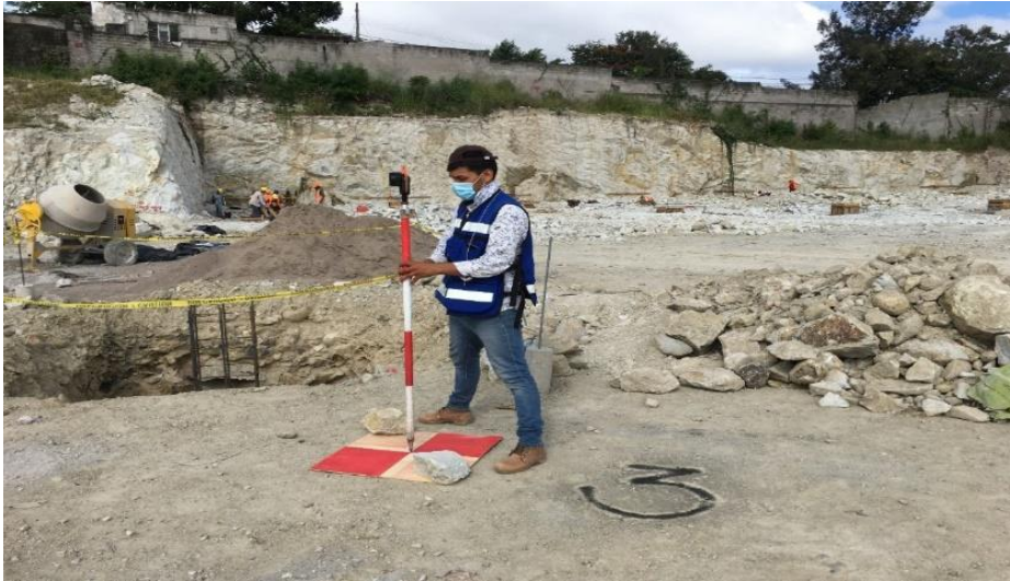
Ilustración 17: Triangulación y georreferenciación de Puntos de Control (PCs) con Estación Total
