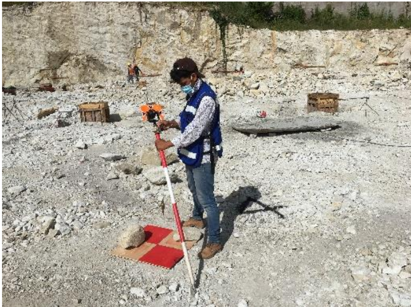
Ilustración 10: Equipo y personal convencional para el Levantamiento Topográfico
