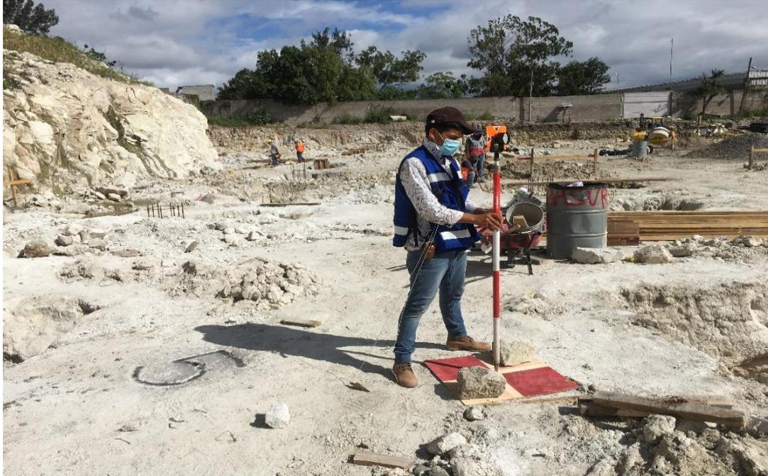
**NOTA:** Cadenero utilizando prisma para la georreferenciación de punto de control n°5 (PC5) durante el levantamiento topográfico con Estación Total. Fuente propia. Col. Las Torres, Comayagüela; Honduras. 7 de Noviembre del 2021.
