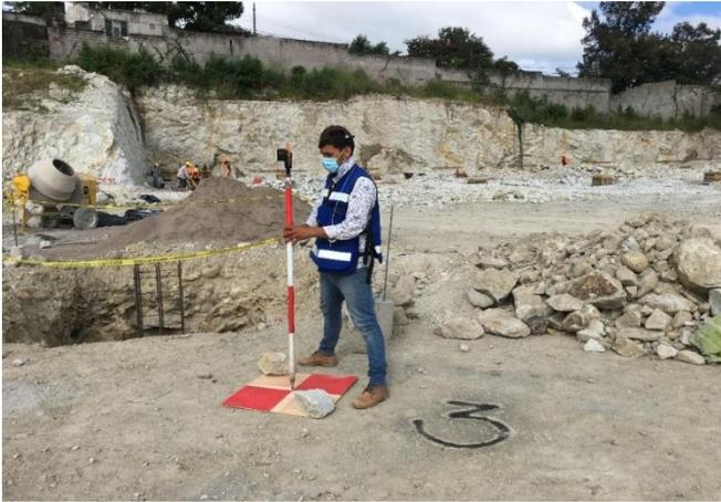
**NOTA:** Cadenero utilizando prisma para la georreferenciación de punto de control n°3 (PC) durante el levantamiento topográfico con Estación Total. Fuente propia. Col. Las Torres, Comayagüela; Honduras. 7 de Noviembre del 2021.
