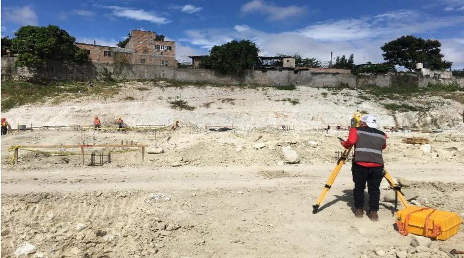
**NOTA:** Cuadrilla de topografía convencional desarrollando un levantamiento topográfico y de georreferenciación de los Puntos de Control (PCs) para fotogrametría; distribuidos de manera aleatoria y estratégica sobre el área de estudio. Fuente propia, Col. Las Torres, Comayagüela; Honduras. 7 de Noviembre del 2021.
