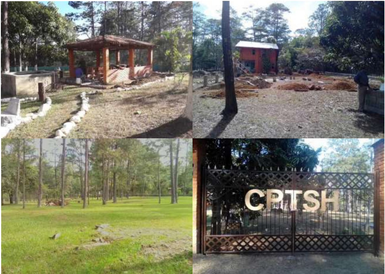
Figura 1. Estado previo del terreno en Valle de Ángeles: (a) Kiosko y pila de agua, (b) Casa de campo existente, (c) Vista panorámica, (d) Portón de entrada. Fuente: Padilla (2018, p. 53)
